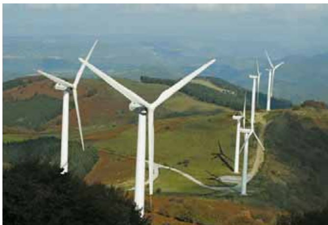
Un parc d'éoliennes en Aveyron.
