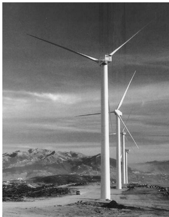
Parc éolien de la cimenterie Lafarge, 10,2 MW
