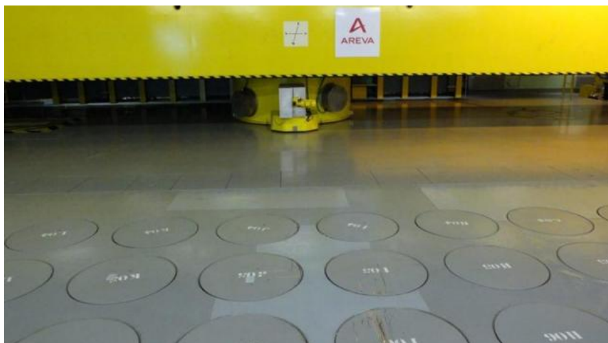
Les colis de déchets vitrifiés sont entreposés dans des puits en inox, de 20 m de profondeur (13 colis/puits) sous cette dalle de béton de 1,70m d'épaisseur. Photo : Ouest-France (10/2013)
